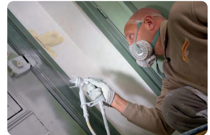
können. Mittels Tempspray-Verfahren wird der Lack erwärmt, so dass mit deutlich geringerem Druck gespritzt werden kann. Das reduziert den Sprühnebel, führt zu einem noch besseren Verlauf und zu einer schnelleren Trocknung.
