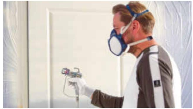
Im Hotel findet man eine Vielzahl von Türen, Heizkörpern usw. Durch die Airless-Spritzapplikation werden Lackierarbeiten rund 30 Prozent schneller ausgeführt, als bei konventioneller Pinsel- bzw. Rollenapplikation.
